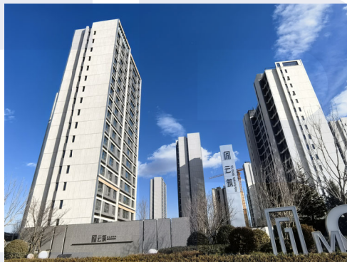
金隅昆泰云筑
