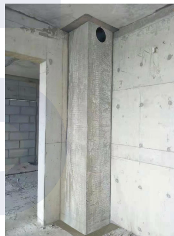
机制排气道截面（毗连型）
