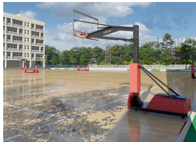
木塑运动地板（室外）实景图
