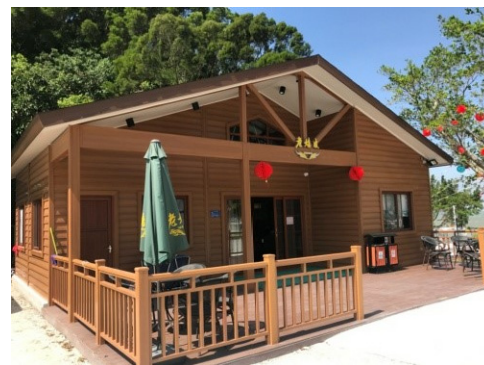
惠州巽寮湾 室外木塑装饰墙板、 木塑栏杆、室外木塑铺板
