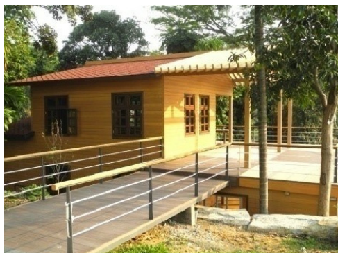
广东省林科院旧房改造项目 室外木塑装饰墙板、室外木塑铺板
