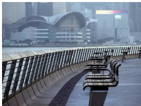
香港星光大道 室外木塑铺板、木塑栏杆和木塑座椅
