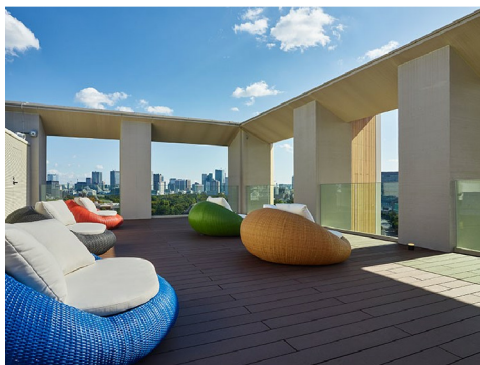
日本东京奥运会场馆 室外木塑铺板
