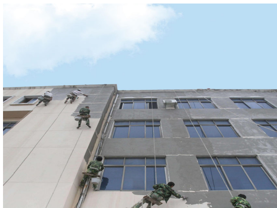
应用场景：旧墙翻新
