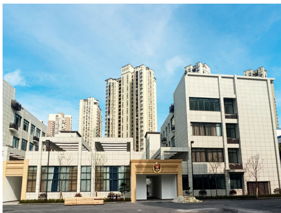
工程案例：重庆长寿消防局
