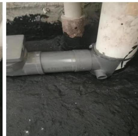
装配式 ABS 管道同层排水系统现场施工照片
