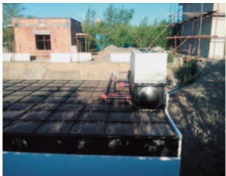
独山子石化公司泵站
