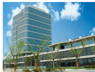
上海洋山港保税区行政大楼
