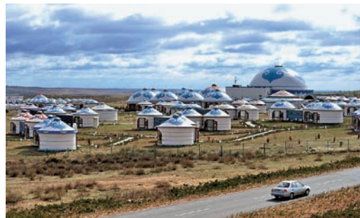
内蒙古鄂尔多斯保温隔热工程
