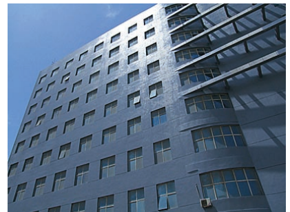
亚宝墙体旧楼改造工程
