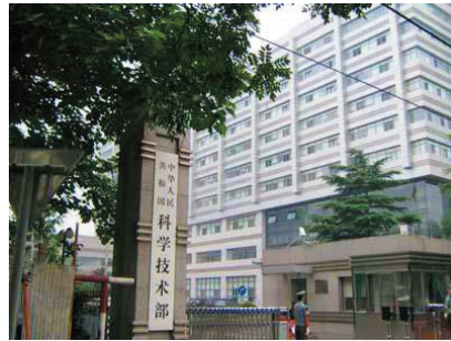
中国科技部办公大楼屋面工程
