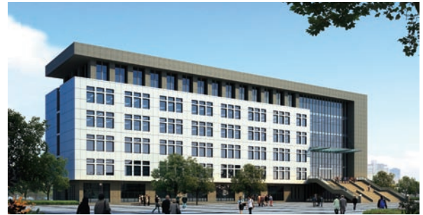
晋中监狱教学楼 外墙保温隔热工程
