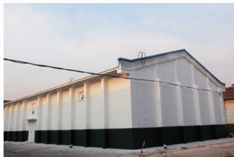
山西鸣李粮食储备库保温隔热工程
