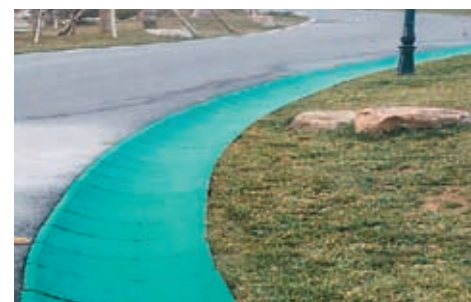
合肥翡翠广场 (弧形盖板)
