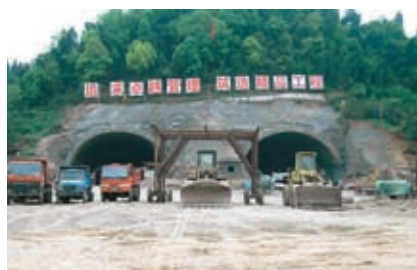
宜昌张家湾隧道
