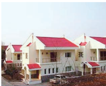
涉县石岗养护中心
