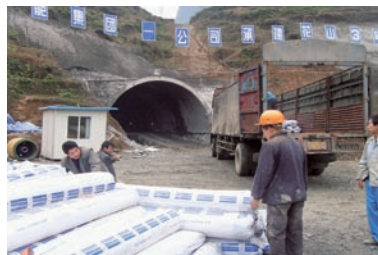
西阳钟渤隧道
