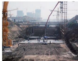
合肥地铁1号线
