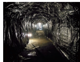
国家电网华商电力管道项目
