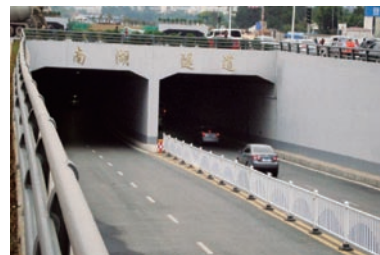
南宁南湖湖底隧道
