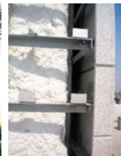
上海银行数据中心机房幕墙
