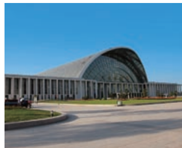
京沪高铁天津西站
