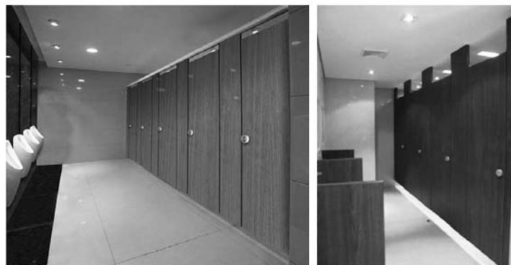
HPL复合板木纹卫生间隔断(图示为中信证券安装实例)
