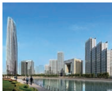
天津津门津塔
