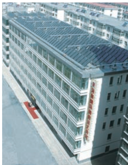
山西长治益东国际酒店 工程类型：平板集中供水系统 规模：480m 2
