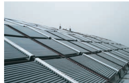
天津宁河医院太阳能工程 工程类型：联集管集中供水系统 规模：280m 2
