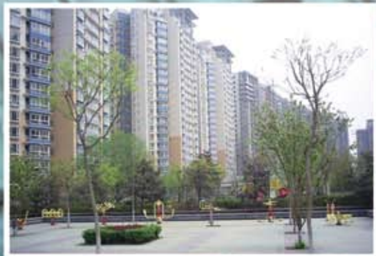
瑞源恒温模块地暖小区供暖供冷系统
