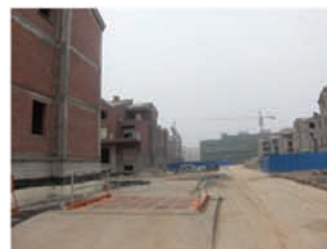
中国对外建设总公司承建山东东营里奥别墅群（仿劈开砖）
