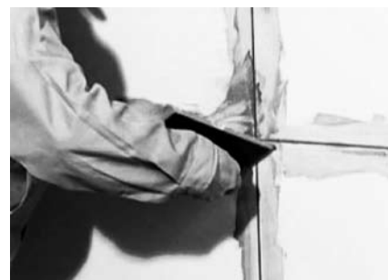
填缝剂施工
