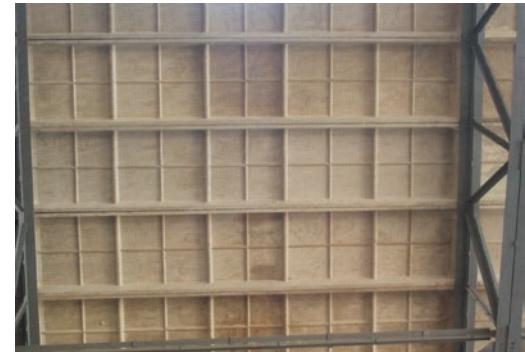
曲寨电厂8m预应力GRC屋面板安装后效果
