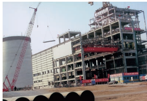
9m超大型屋面板安装
