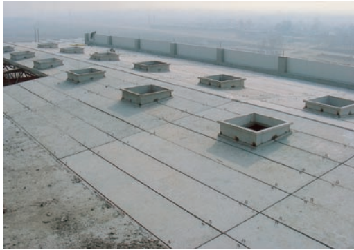
迁安热电厂9m屋面板安装后效果
