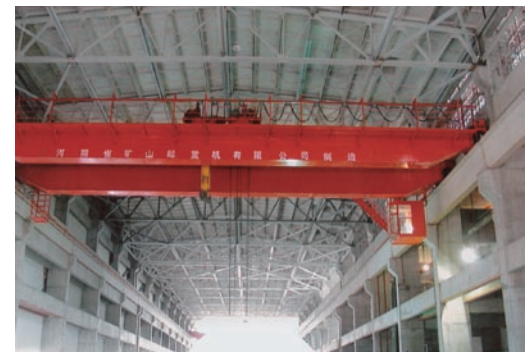
10m超大型屋面板安装效果
