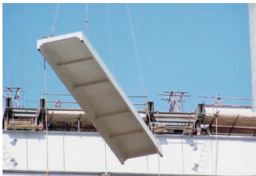
正在吊装中的大型屋面板
