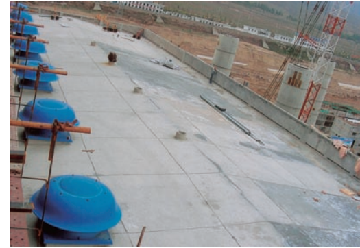
10m预应力屋面板安装后效果
