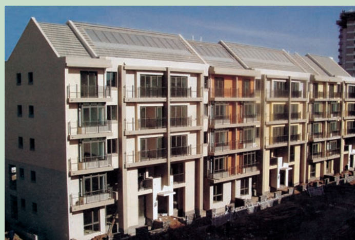
图2 结构型太阳能集热器安装效果实例
