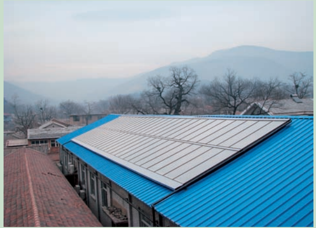
潭柘寺太阳能采暖/热水工程 项目规模：960 m 2 系统功能：采暖/热水 建成时间：2007年
