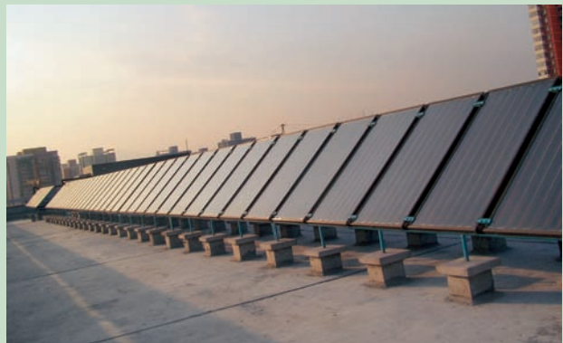
首钢工学院太阳能热水工程 项目规模：642 m 2 系统功能：热水 建成时间：2007年
