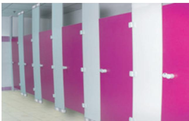
三、酚醛树脂高压板（又称抗倍特板、倍耐板）的卫生间隔断产品，以其高强度、结实性、牢固性确立了在卫生间隔断材料的领导地位，一经面世便得到了大量使用，也成了20世纪末和本世纪初高档卫生间隔断产品的代名词。安装类型和五金件与高压木制板相同，因板材高质量而得到迅速普及。但其缺点是易受环境温度影响，板材易变形。材料亦不能二次利用，浪费能源，严重影响使用效果。
